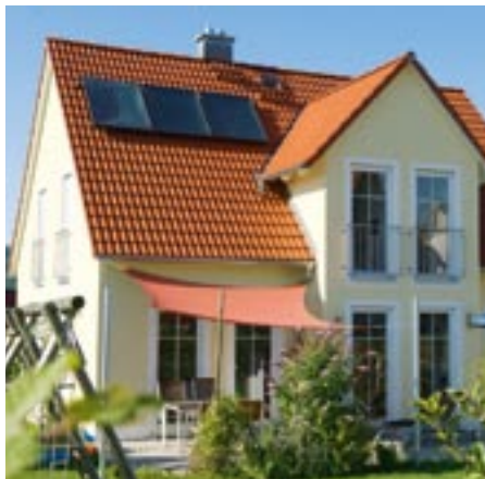
Schon wenige Solarelemente können die Erdgasheizung wirkungsvoll unterstützen, die Einsparung an Primärenergie ist beachtlich.
