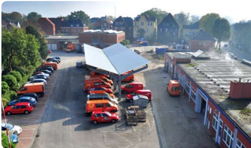
Im Bau: die neuen Gebäude der Stadtwerke Emden. Fertigstellung Mitte 2012.
