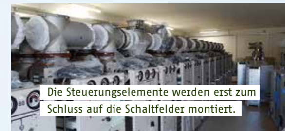
Blick auf das Doppelsammelschienensystem mit den drei Phasen.
