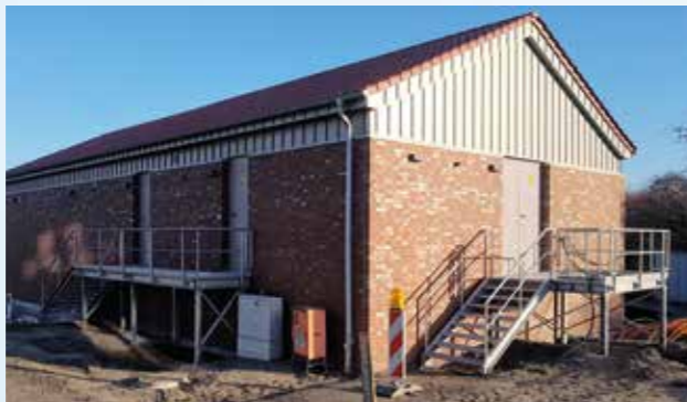
Das Schalthaus: innen Hightech, außen klassischer Klinker.
